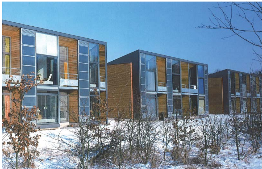
Boligbyggeri med solceller integreret i facadebeklædningen
