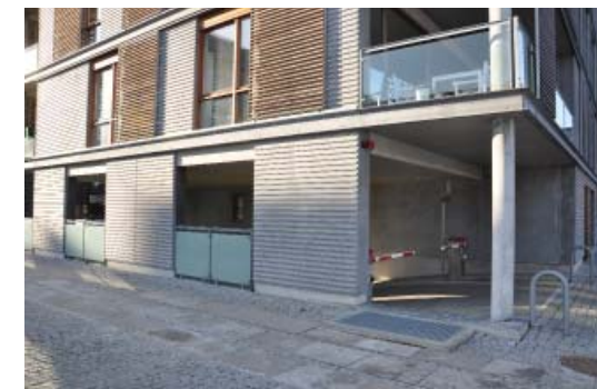
Nedkørsel til P-kælder
