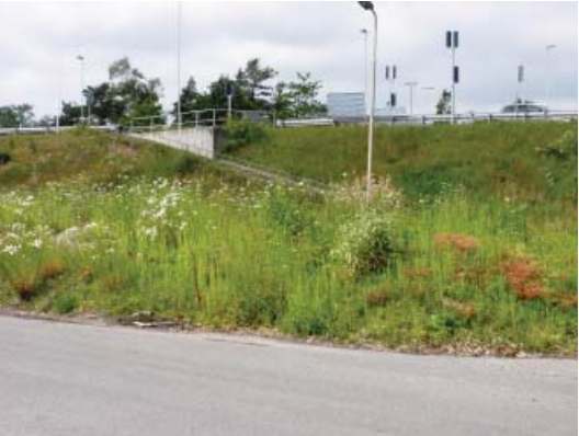
Terrænspring ved ny vejtilslutning til Sdr. Boulevard
